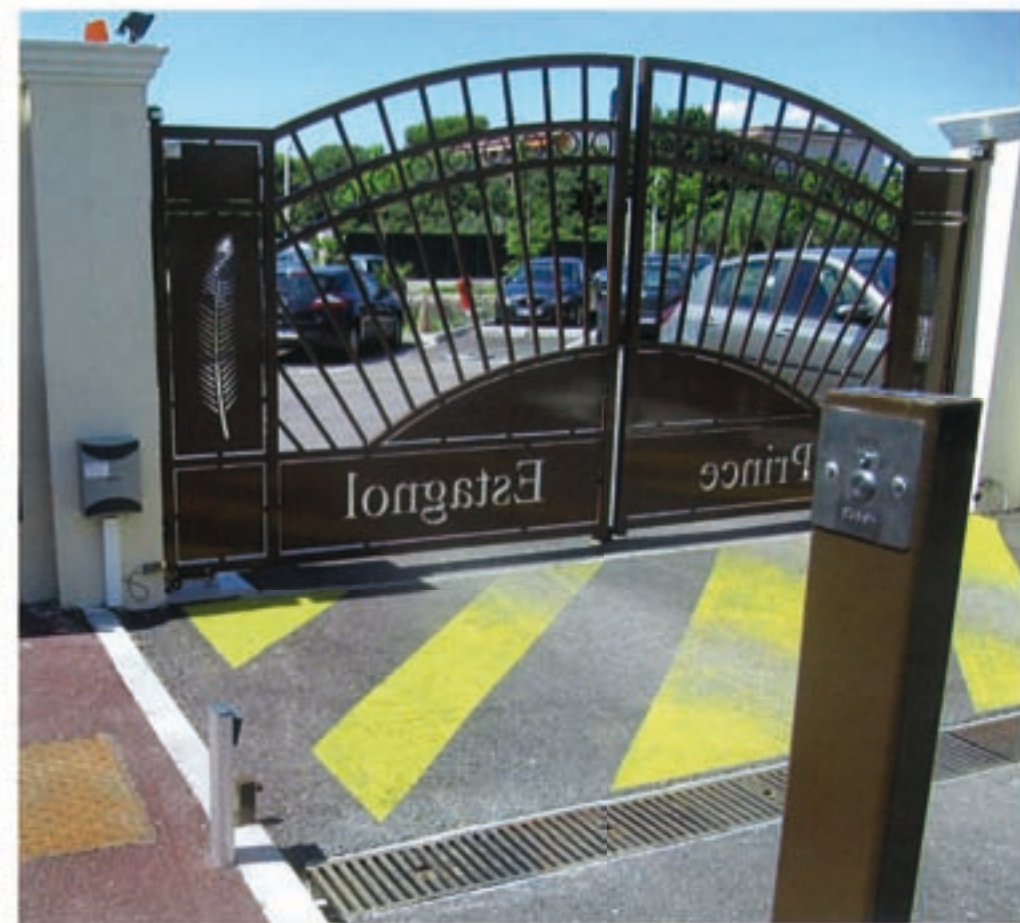
Le bouton de sortie éloigné de la porte et du portail
